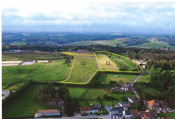
Figure 2 : Photo aérienne des cellules C1-C2
