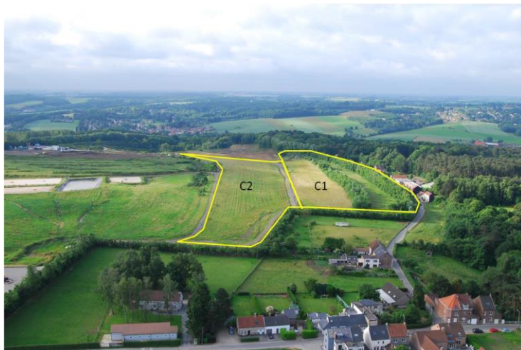
Figure 2 : Photo aérienne des cellules C1-C2
