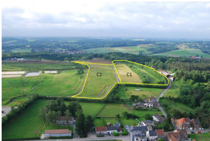
Figure 2 : Photo aérienne des cellules C1-C2
